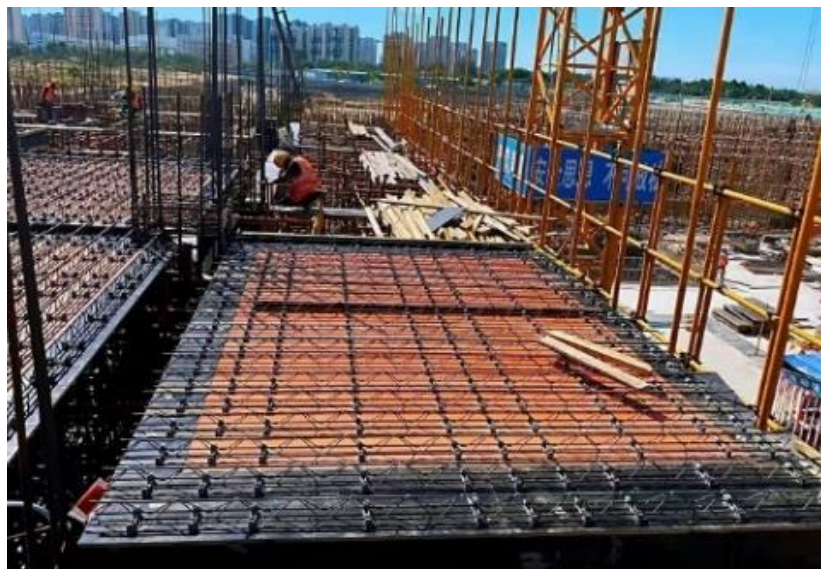
钢筋桁架楼承板的应用
