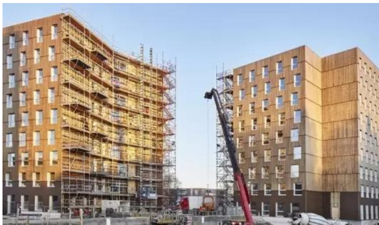
挪威Trodheim市于2016年建成的学生公寓Moholt50|50，采用CLT剪力墙结构。
